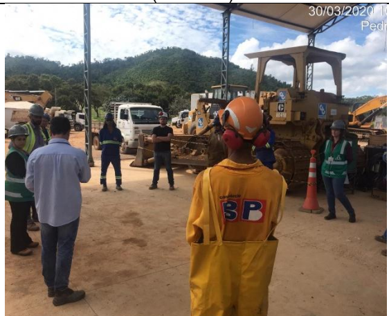
Foto 18 – Roda de conversa sobre as medidas adotadas na obra – Mecânica (30/03/20).
