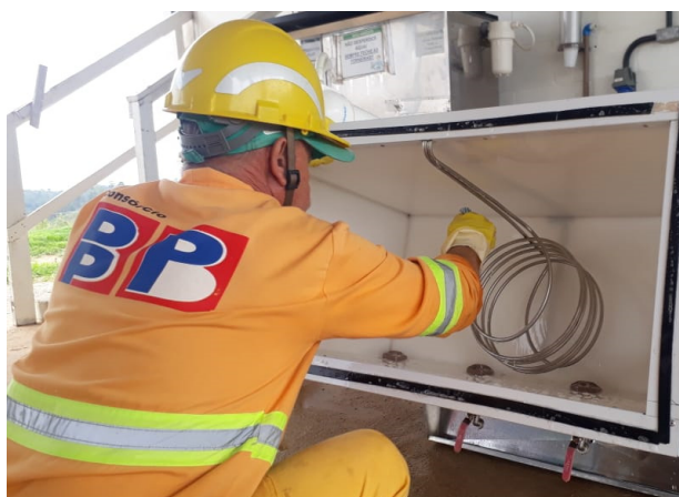
Foto 27 – Higienização e limpeza de bebedouros no canteiro operacional (03/04/20).
