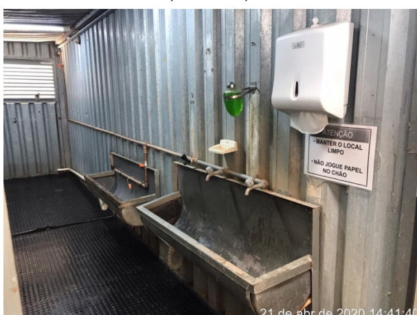
Foto 25 – Limpeza dos banheiros. (21/04/20).
