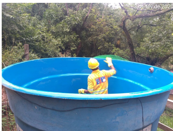
Foto 17 – Limpeza da caixa d'água (03/02/20).
