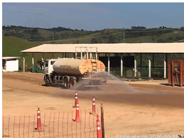
Foto 30 – Umectação de vias internas (13/04/20).
