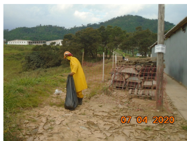
Foto 26 – Limpeza e organização na área do almoxarifado (07/04/20).
