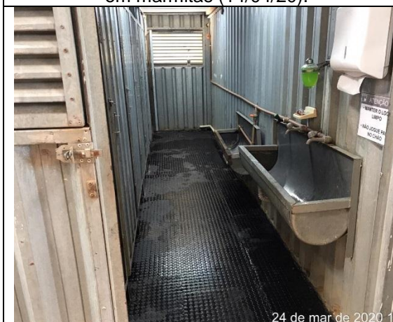
Foto 101 – Higienização dos banheiros e disponibilidade de sabão (24/03/20).
