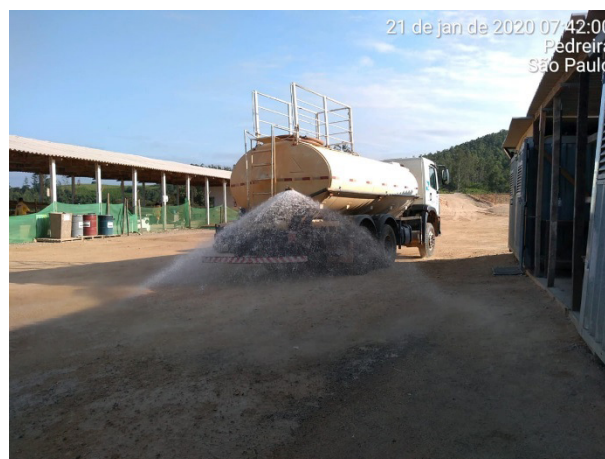
Foto 12 – Umectação de vias internas (21/01/20).
