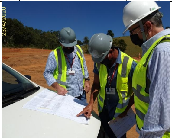
Foto 90 – Uso constante de máscaras no canteiro de obras (23/04/20).
