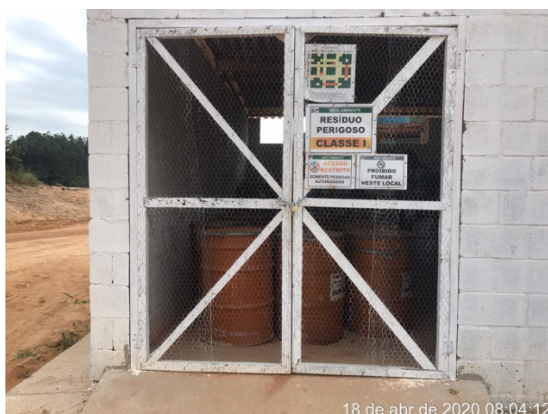
Foto 23 – Baía de armazenamento de resíduos perigosos classe I no canteiro operacional (18/04/20).
