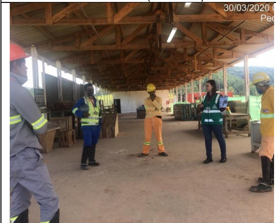
Foto 15 – Roda de conversa sobre as medidas adotadas na obra – Elétrica (30/03/20).
