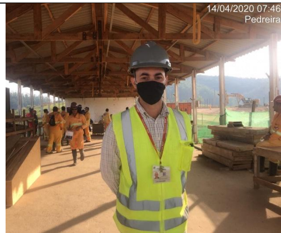
Foto 46 – Máscara distribuída para uso contínuo no canteiro de obras (14/04/20).
